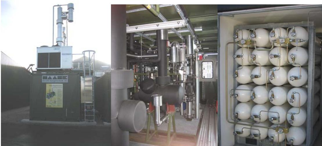
Abbildung 3-15: Aufbereitung von Biogas auf Erdgasqualität bei der Biogastankstelle Jameln: Container (links) und Blick auf die Gasaufbereitung im Inneren des Containers mit einer Leistung von 140 m<sup>3</sup>/h; rechts Drucklagertank; eigene Fotos
